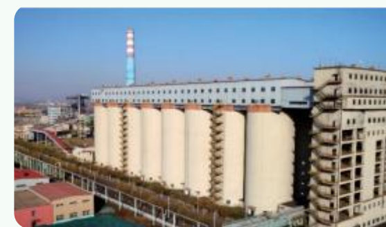
焦化儲煤筒倉
