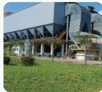
二煉鋼二次除塵系統
