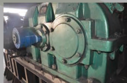
改善后图片（储运公司焦B103皮带线）：机头设备清扫较好，无较重积灰
