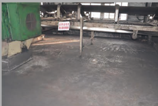
改善后图片（储运公司煤B104皮带线）：地面卫生清扫较干净，皮带支架无积灰
