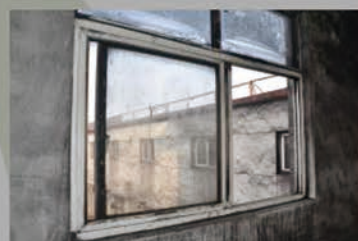
改善后图片（储运公司煤B105皮带线）：现场窗户无积灰、较干净，且每周定期清扫
