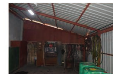
改善后图片（炼焦分厂顶装焦炉中石维修点）：工具柜内工具摆放整齐和定位明确，各类物品使用专用挂钩和架子定置存放
