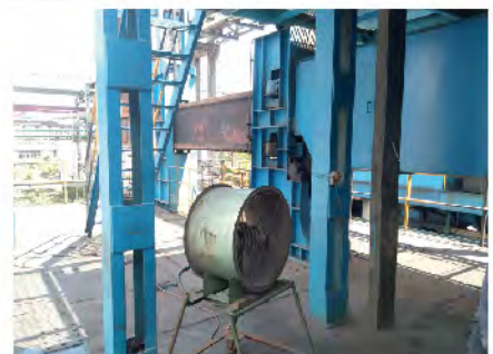
▶整改后图片（炼焦分厂捣固2#推焦车）：完成整改
