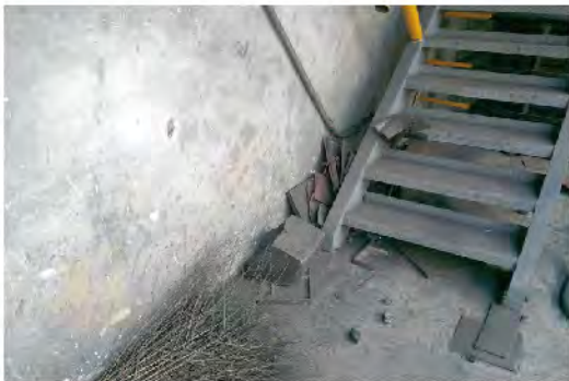
▲问题图片（炼焦分厂捣固2#装煤车）：控制开关裸露在外，无防护措施。处罚100元
