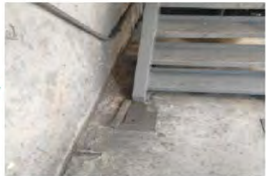
▲整改后图片（炼焦分厂捣固晾焦台）：完成整改
