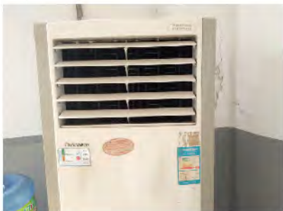
▲整改后图片（炼焦分厂捣固调火排班室）：完成整改
