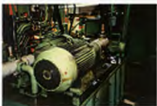
马达布满灰尘且没有过滤器
